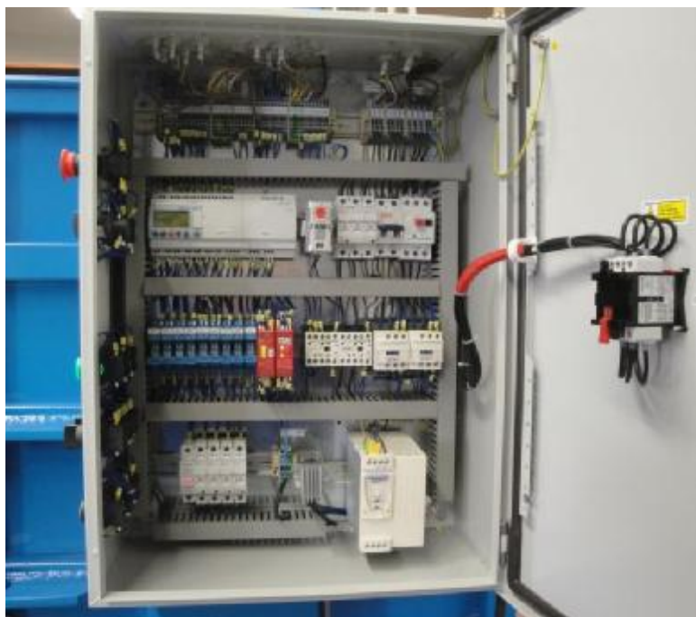
Uspořádání rozvaděče s vnitřním vytápěním
